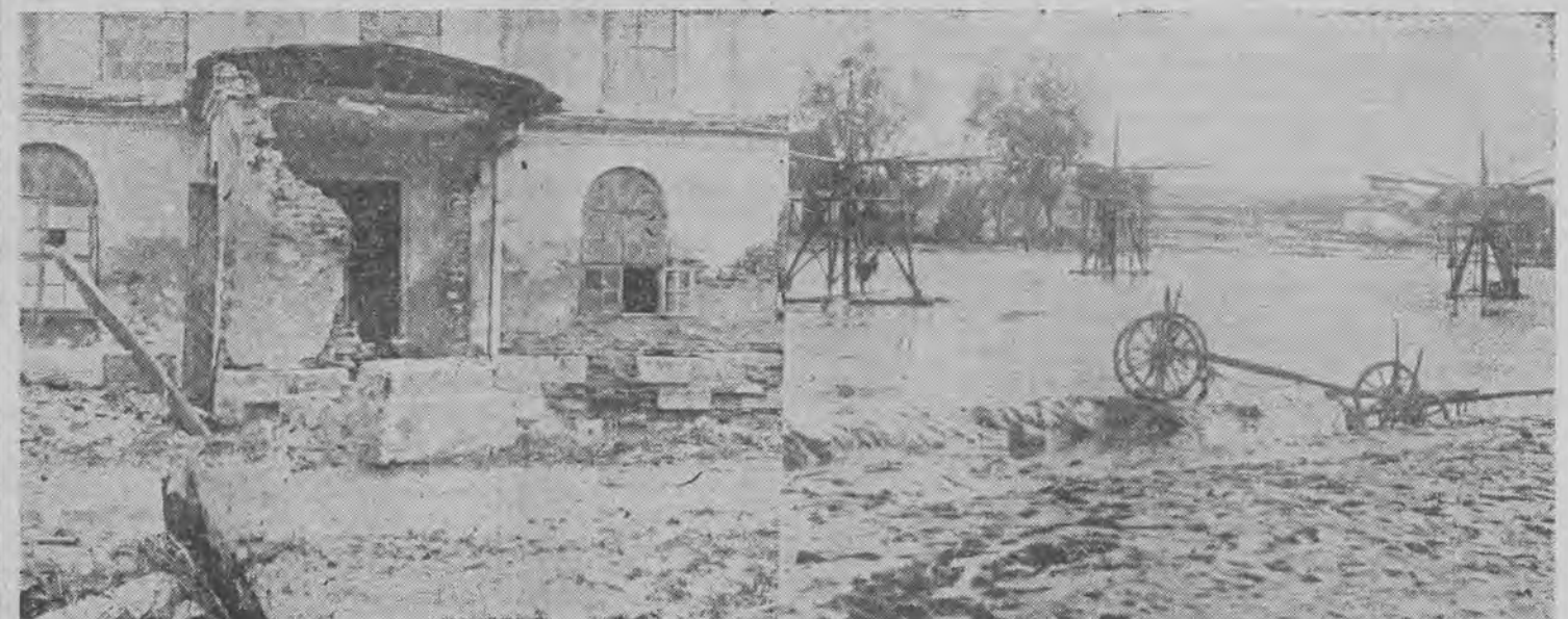
Straszny obraz zniszczenia przedstawia Działoszyn nad Nidzicą, gdzie wskutek nagłego wylewu straciło 19 osób życie, 17 domów woda zniosła bez śladu, a uszkodziła 70 w takim stopniu, że muszą być rozebrane. Na fotografiach: zalana dzielnica — w głębi zniszczony domek; zburzony portal synagogi.
