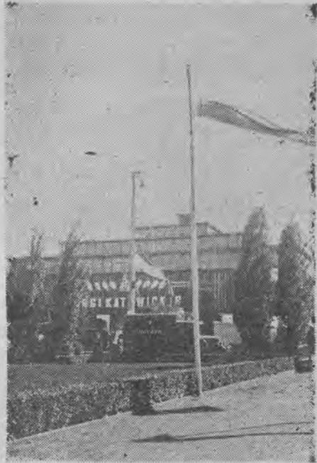
Widok na główny pawilon Targów Katowickich.
