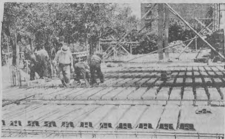
Budowa gmachu biblioteki publicznej w Łodzi
