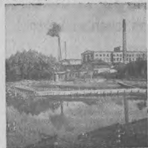
Prace przy regulacji rzeki Wolburki w Tomaszowie.
