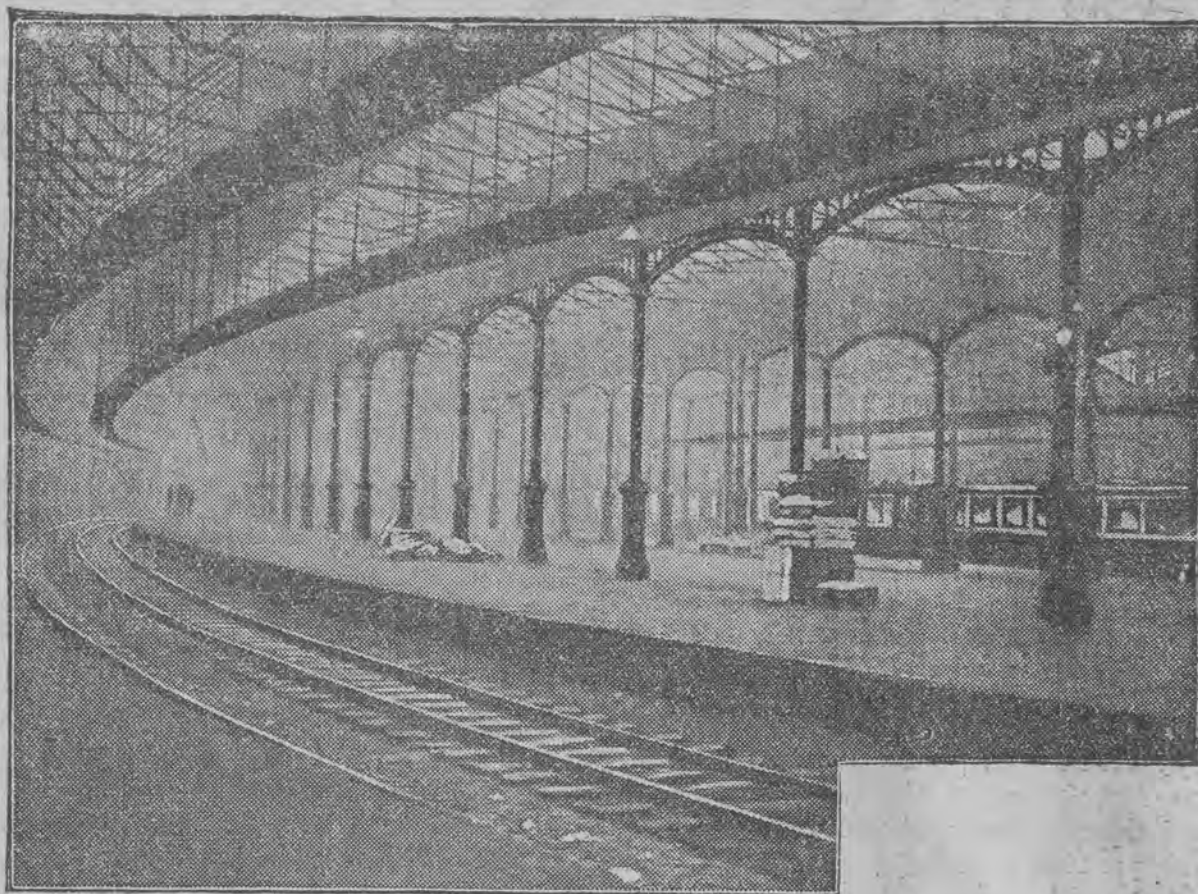
Największy dworzec świata został wybudowany pod Londynem. Jest on obliczony na przyjęcie i wyekspedjowanie 25.000.000 ludzi, którzy zwidzą wystawę imperjum brytyjskiego.
