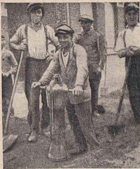
Przyrząd elektrycznie uruchomiony do ubijania ziemi.
