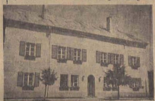
Das Amtsgebäude in Golina
