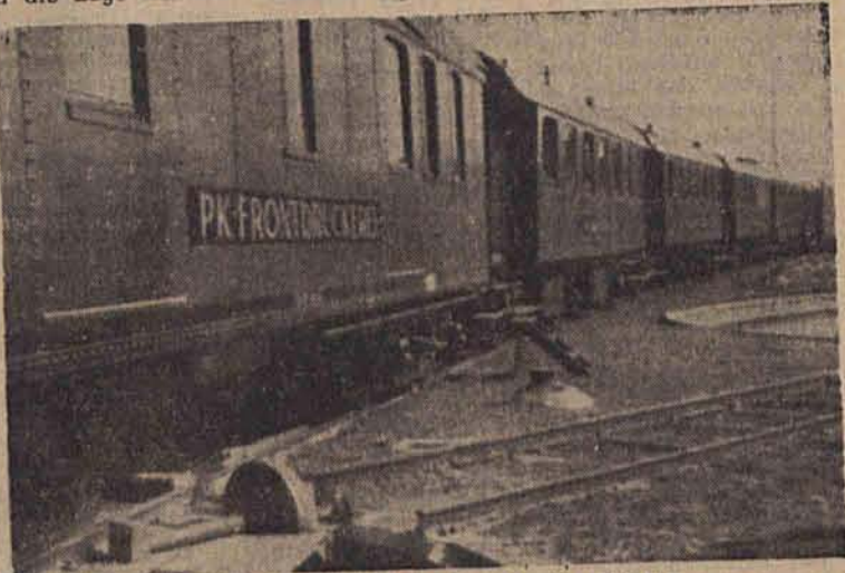
Außenansicht eines der Frontdruckerei-Züge
