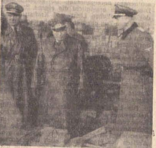
Besichtigung eines Industriewerks (Aufn.: BfL)
