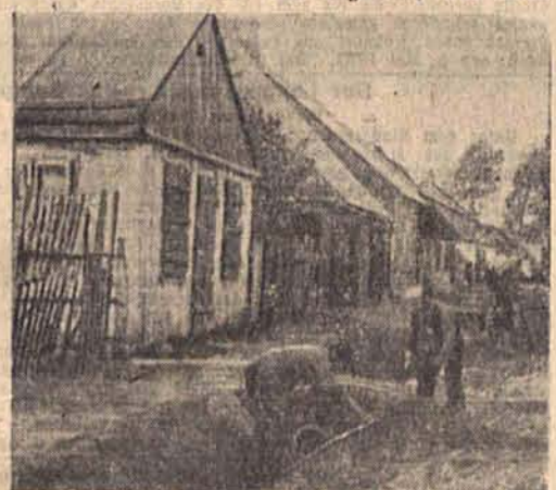
Auch bei diesem selbsterzählten in Osmolin (Amtsbez. Zd. Wola-Land) durchgeführten Straßenbau wurde zuerst für Entwässerungsgräben und Durchlässe gesorgt. (Aufn.: A. Schmelich)
