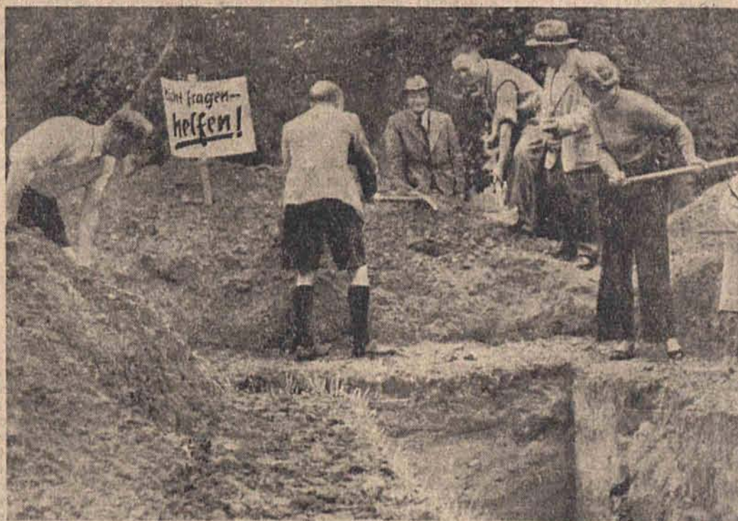
Hausgemeinschaft baut einen Bunker
