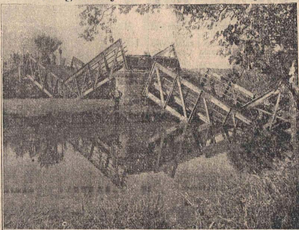
Zniszczony most na granicy czechosłowacko-niemieckiej. Jak wiadomo, przerwane zostały wszelkie połączenia na tej granicy.
