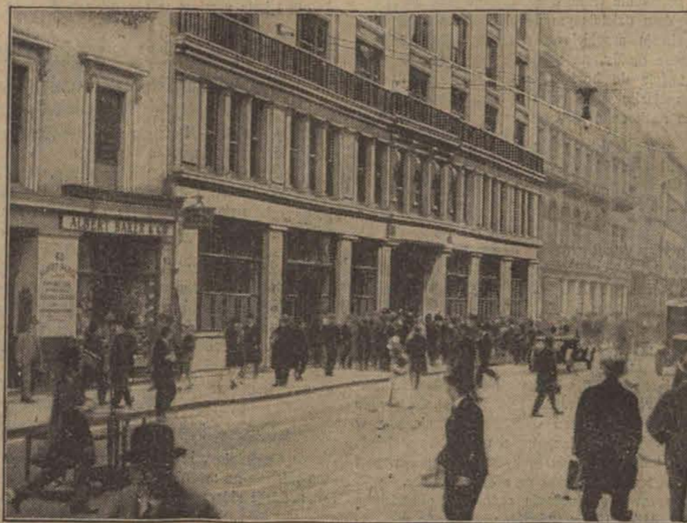
Tłumy publiczności przed budynkiem sowieckiego przedstawicielstwa handlowego „Arcos” w Londynie podczas rewizji, przeprowadzanej przez policję.
