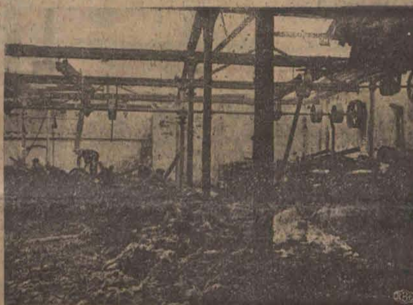
Zgłoszcza spalonej przedalni Lejzora Pływackiego przy ulicy Kilińskiego 102. Od niedogaszzonego ognia zajęła się sąsiednia cialnia T. Finstera przy ul. Juliusza.
