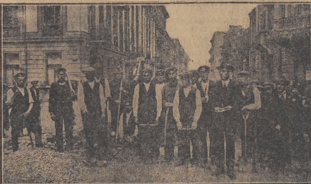
Roboty brukarskie na ulicy Zawadzkiej (róg Zachodniej).
