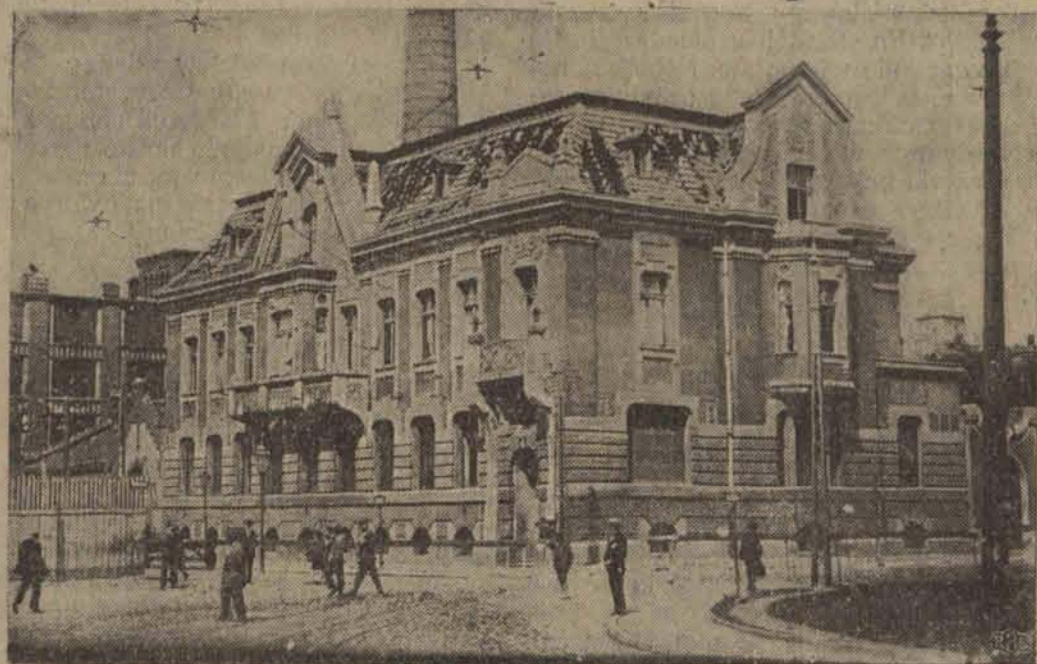
Willa p. Kestenberga przy Placu Dąbrowskiego ze zniszczonym wskutek eksplozji dachem.
