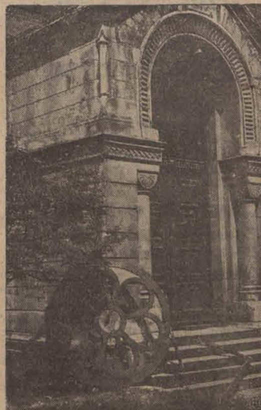
Wywalone siłą sobotniej eksplozji okno nad bramą wejściową gmachu Domu Starców przy ulicy Narutowicza.
