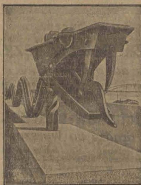
Pomnik w stylu nowoczesnym wyobrażający walkę z powodzią. Rozhukany żywioł przedstawiony jest w postaci żelaznego węża, którego głowa jest przebita grotami. (W)
