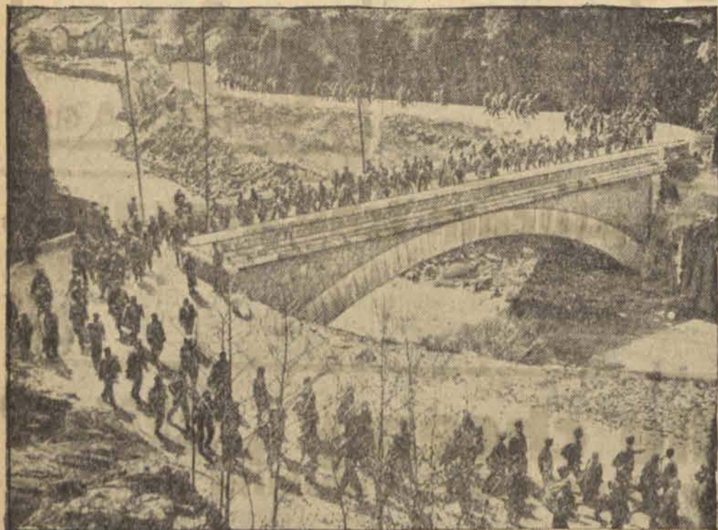
Całymi oddziałami przechodzą milicjanci przez graniczny most na jednej z szos pi-renejskich do Francji, skąd po odpoczynku i nowym wyekwipowaniu i uzbrojeniu wracają znowu do Barcelony. (Za mostem teren Hiszpanii, przed mostem Francja).
