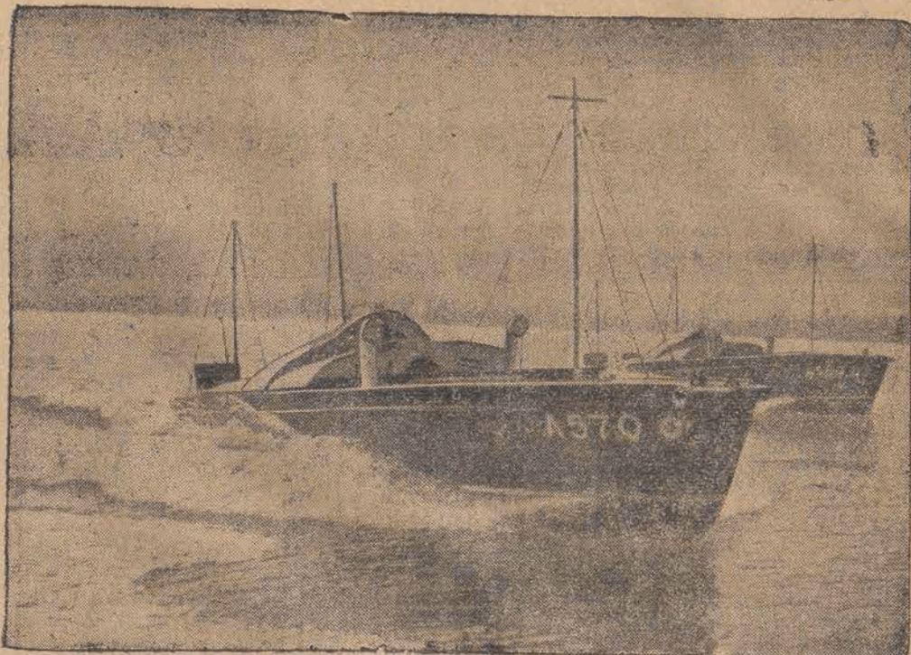
Dwie opancerzone szybkobieżne łodzie bez załogi, kierowane za pośrednictwem radia służą angielskiej flocie do wypróbowania celności artylerii okrętowej.
