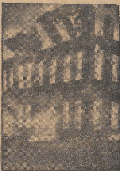
Podczas pożaru fabryki chemicznej w Barton Ville (St. Zj.) udało się fotografowi zdjąć walące się mury.
