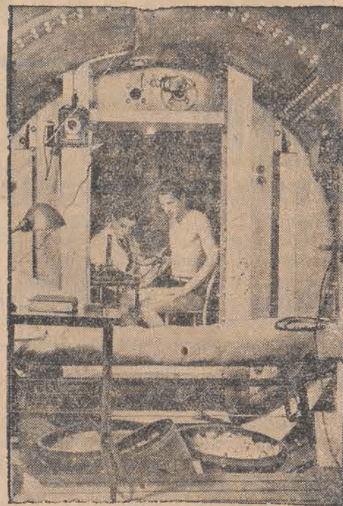
W Milwaukee została zbudowana specjalna komora dla wypróbowania wytrzymałości nurków, którzy przebywają w niej przez 12 godzin pod zwiększonym ciśnieniem.
