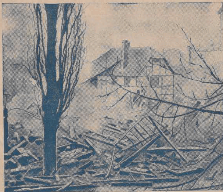
W miejscu kąpielowem Pymont w Niem- czech groźny pożar strawił hotel oraz szereg dalszych budynków. Mieszkańcy zaledwie uratowali swe życie.
