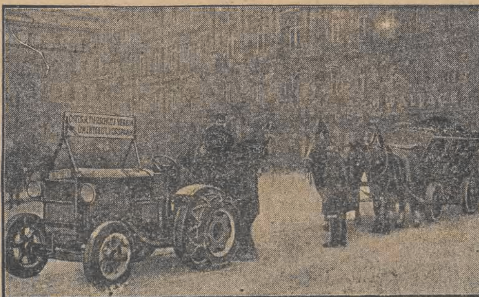
Wiedeńskie towarzystwo opieki nad zwierzętami uruchomiło w bieżącym roku 30-konny traktor, który ma za zadanie pomagać koniom w przewożeniu wielkich ciężarów na specjalnie śliskich jezdnich.
