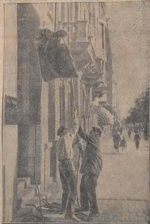
W Holandji zastosowano na dachu każdego domu dźwig, który umożliwia transportowanie różnych przedmiotów przez okna, by nie nadwyżać tragicznie.
