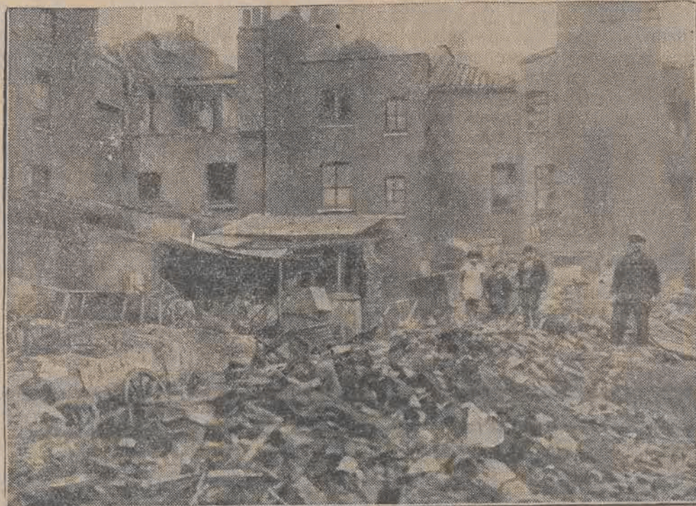
W Londynie przystąpiono do rozbioru domów w t. zw. dzielnicy nędzy, w których ludzie mieszkali w straszliwych warunkach sanitarnych. Na miejsce zburzonej — zbudowana będzie nowa dzielnica.
