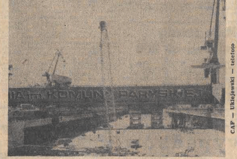
Na budowie drugiego suchego doku w Stoczni im. Komuny Paryskiej w Gdyni dobiegają końca prace związane z oddaniem nieckii dokowej. Będzie ona mogła pomieścić kadłuby o nośności 200 tys. ton. Dzięki sprawniej pracy i organizacji, szwedzka firma „Skanska Cementgjuteriet” i współpracujące z nią polskie przedsiębiorstwa skróciły termin oddania nieckii o 6 m-cy. N/z: widok na nieckę II suchego doku.
