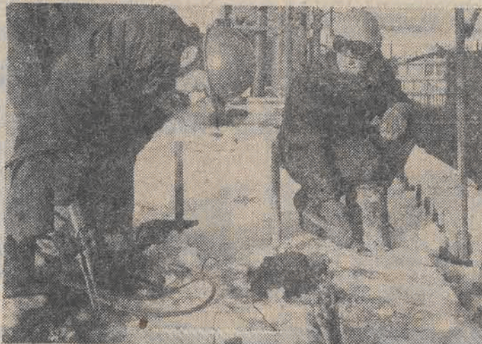
N/z: budowa hali siłowni w elektrowni szczytowo-pompowej w Żarnowcu.
