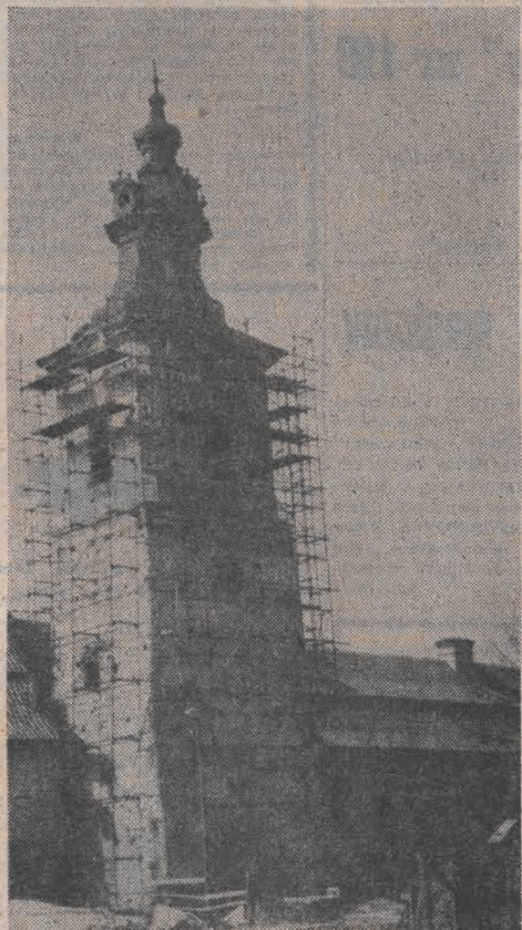
N/s: Brama Krakowska w trakcie remontu. Foto: J. Cyperling
