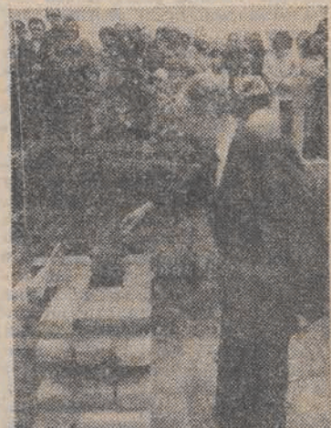
W Lublinie odbyło się I Wyjazdowe Prezydium Krajowego Komitetu Narodowego Czynu Pomocy Szkole. Momentem kulminacyjnym było wmurowanie kamienia węgielnego pod budowę nowej szkoły w SOBIANOWICACH woj. lubelskiej z Funduszu Narodowego Czynu Pomocy Szkole.
