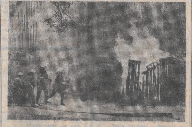
Ogień to coś, czego bardzo nie lubią drewniane komórki, których pełno jeszcze w centrum miasta. Kiedy dym się rozejdzie, zwykle po komórkach niewiele pozostaje. Tak było wczoraj przy ul. Piotrkowskiej 64 (na tyłach). Goście, że znów podjeżdżają się podpalenie... Opr. M. C.
