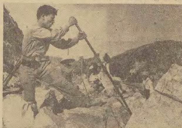
W Demokratycznej Republice Wietnamu stale trwa praca nad odbudową zombardowanych przez USA arterii i węzłów komunikacyjnych, stanowiących dla każdego kraju „unierwienie” wszystkich dziedzin życia i będących niezbędnym elementem rozwoju gospodarki. Na zdjęciu: brygada młodych ochotników pracy odbudowuje zombardowaną drogę.
