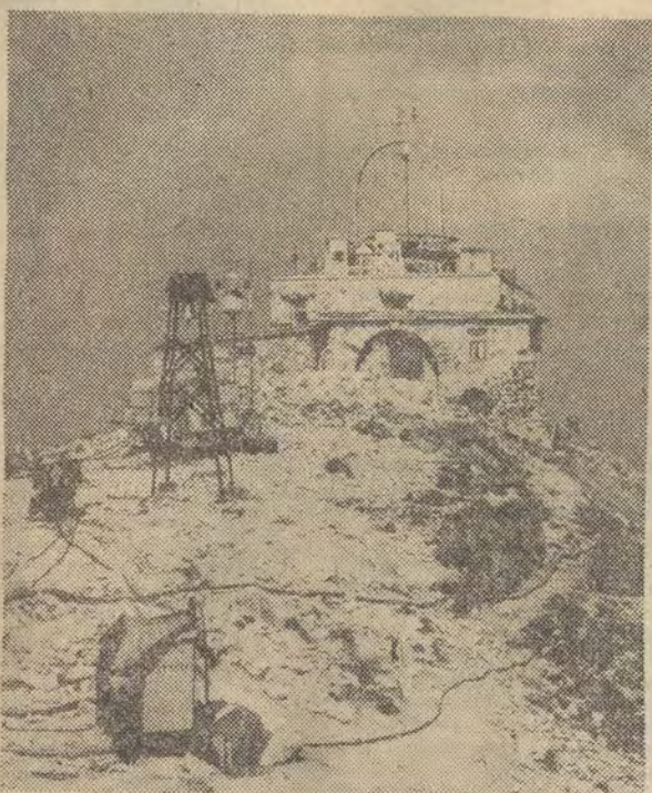
Na zboczu Kasprowego Wierchu w stronę Doliny Goryczkowej trwa budowa linowego wyciągu krzesełkowego dla narciarzy. Na zdjęciu: prace montażowe na Kasprowym.
