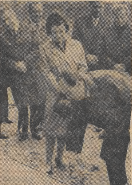
Sekretarz KL PZPR — H. Rejniak dokonuje wmurowania aktu erekcyjnego pod budowę gmachu matematyki
