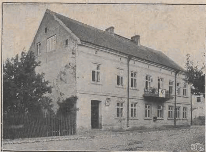
Budynek Kasy Skarbowej w Turku.
