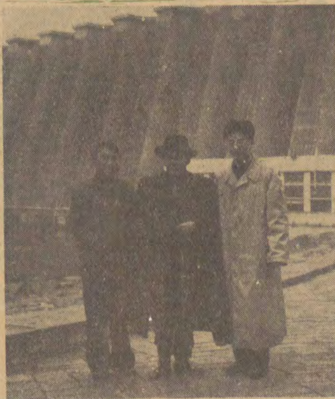
Zapora wodna w prowincji Hofei
