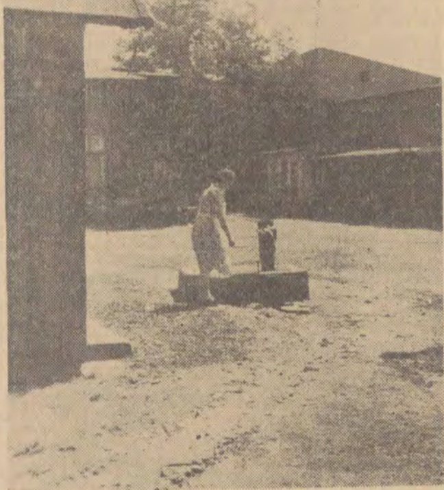
Mieszkańcy tych „komórek” przeniosą się niedługo do nowych bloków.
