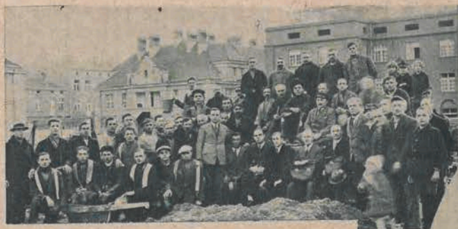
Wykończenie systemem gospodarczym nowego kompleksu domów na osiedlu Tow. „Lokator” przy ul. Lokatorskiej. Kompleks stanowi 5 domów o 124 mieszkaniach, z czego 74 po dwa pokoje z kuchnią i 50 mieszkań po 1 pokoju z kuchnią i wygodami. Komorne obliczane jest li tylko na pokrycie procentów z pożyczki Banku Gospodarstwa Krajowego i koszty rzeczywiste utrzymania domów.
