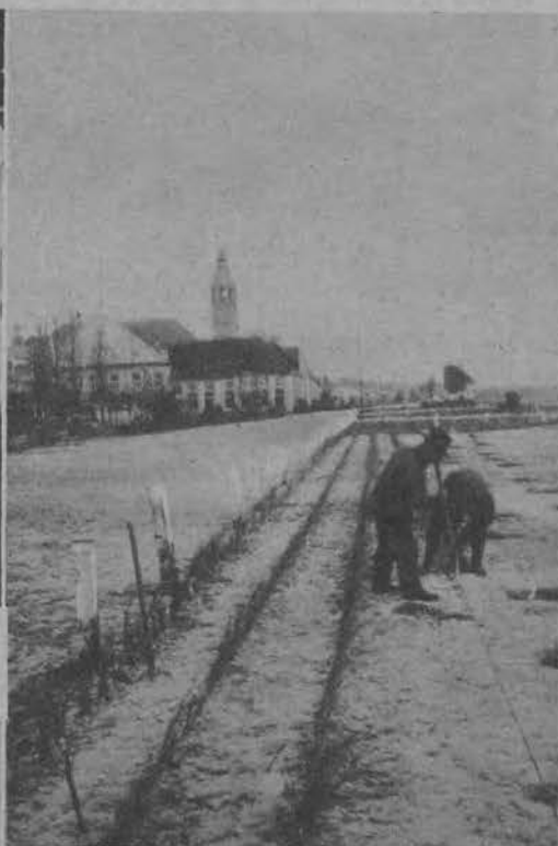
Plaże nadmorskie w Świnoujściu, po zniszczeniu ich przez burze, muszą być na sezon letni odbudowane. Sadzenie wiklin celem umocnienia brzegu.
