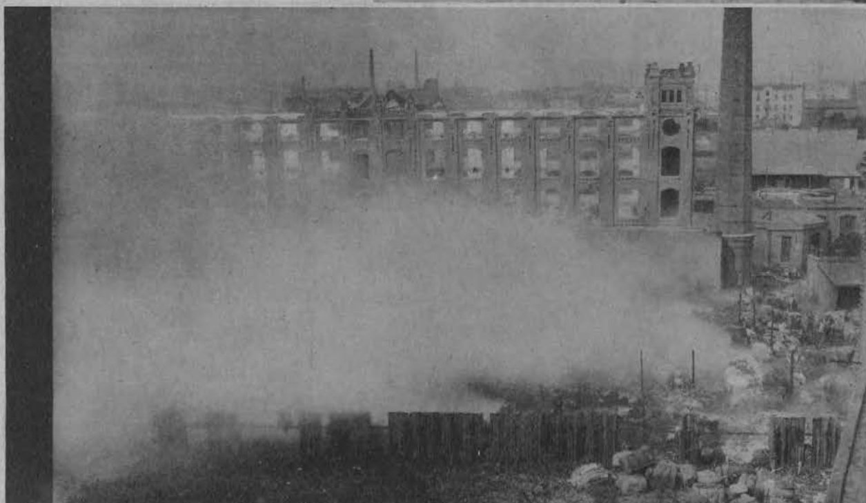
Katastrofalny pożar, wzniesiony uderzeniem pioruna podczas burzy nad Łodzią, strawił doszczętnie budynek fabryczny firmy B. i A. Piotrkowscy, D. Fuks i Ska oraz składy z bawełną. Straty sięgają półtora miliona złotych.
