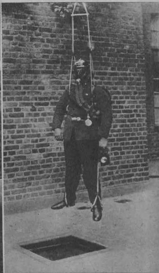
Nowy sposób ratowania ze studni, kanałów, szybów i t. p. Osobę ratowaną ustawia się w dźwig sznurowy i zakłada się maskę tlenową do oddychania.
