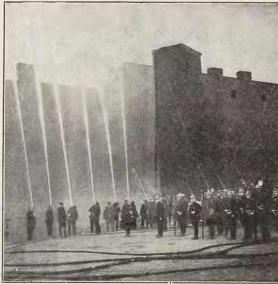
Probe der Autospritzen der 2. Fr. Z. im Hofe des ersten Löschzuges.
