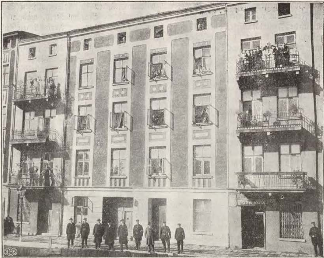
Das Haus der Invaliden-Casse der V. Fr. F. in der Sikulski-Straße.
