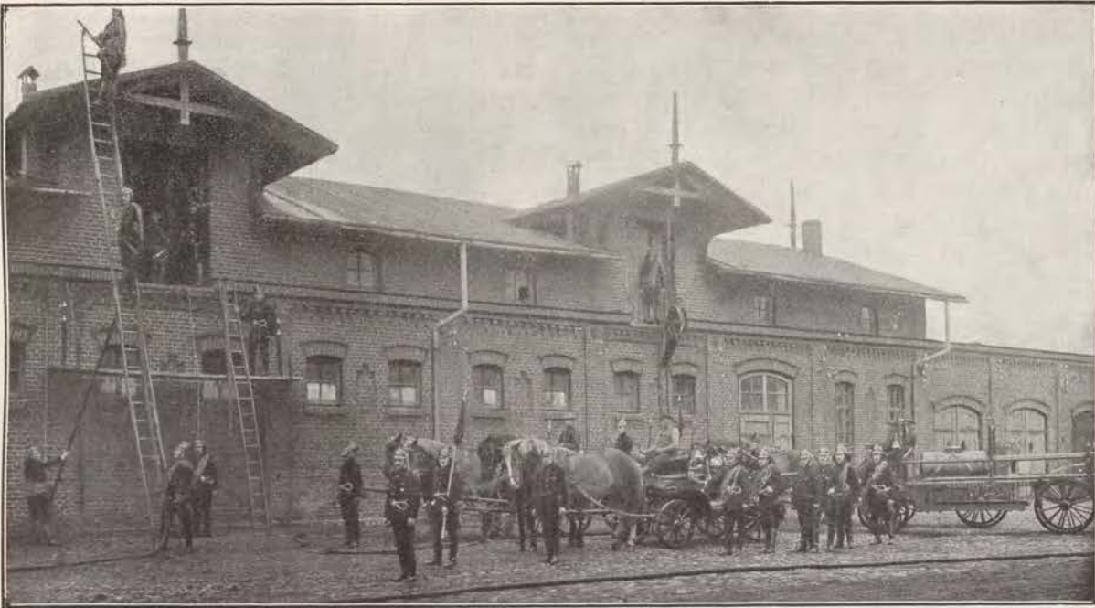
Der achte Löschzug bei einer Übung am Requisitionshause.
