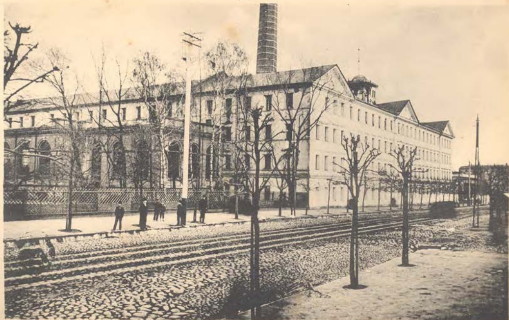
Фабрика Л. Гейера.—Fabryka Geyera.
