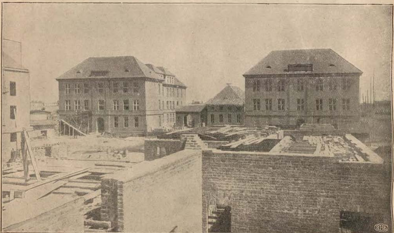
SZKOŁA PRZY ULICY PODMIEJSKIEJ
