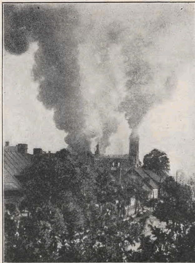
Pożar kościoła katolickiego.
