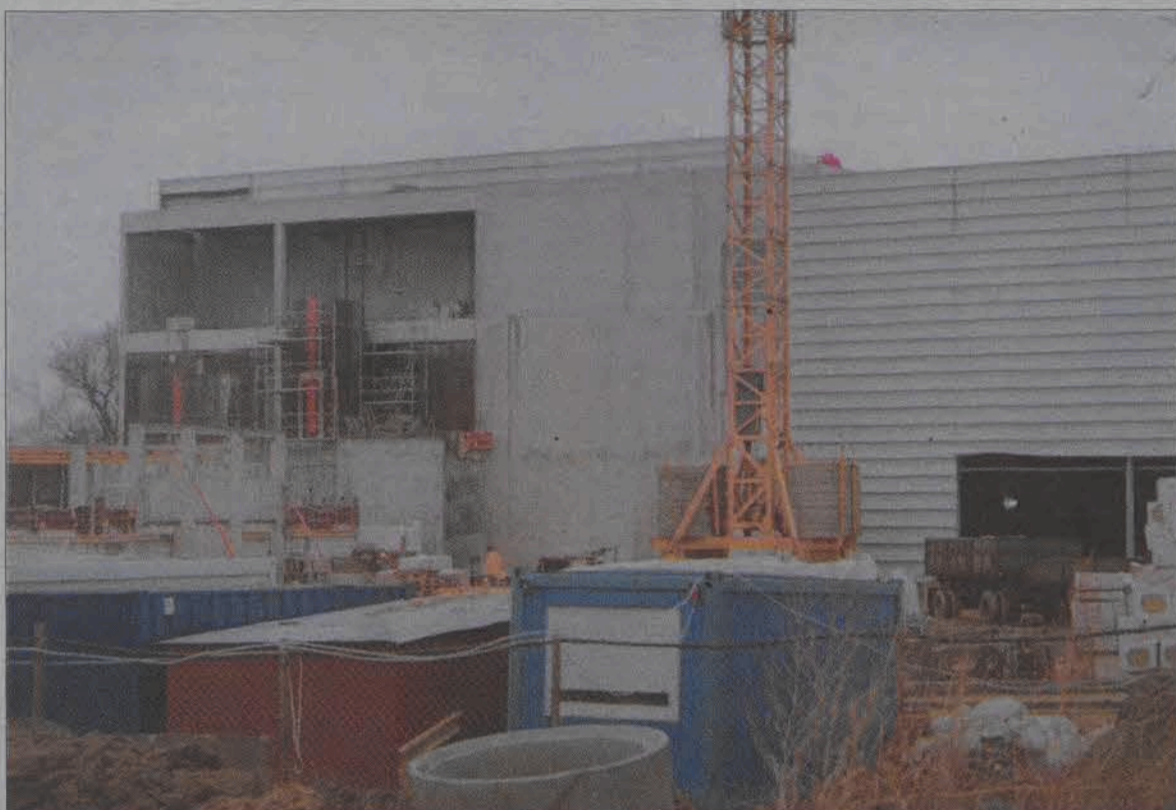
W niektórych miejscach widać jeszcze betonowy, lity szkielet hali.
