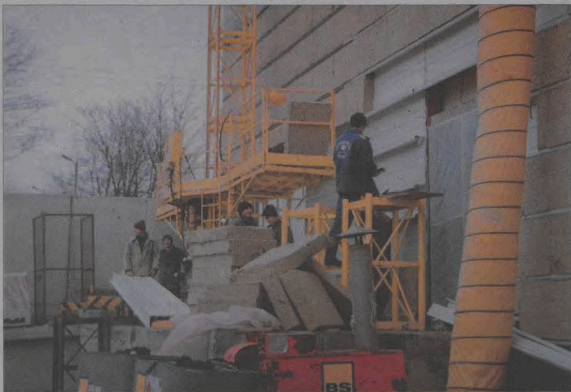
Pod elewacją montowana jest imponującej grubości warstwa izolacyjna
