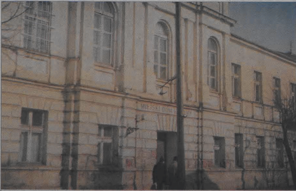
Zrujnowany, przez cztery lata opuszczony budynek MOK przy ul. Podrzecznej będzie remontowany.
