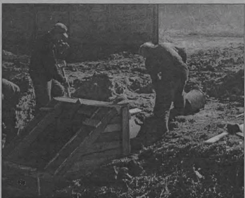
Zakończyły się prace przy budowie końcówki kanału deszczowego na tyłach budynku cechu przy ul. Podrzecznej. Odkryty dotąd kanał, często gniący, skierowano rurą do Malinówki.
