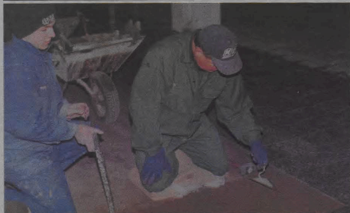
W piątek 9 marca zakończono prace przy układaniu posadzki w kościele Matki Bożej Nieustającej Pomocy na Korabce, w Łowiczu. Powierzchnia 500 m 2 podłogi została pokryta płytkami ze strzegomskiego granitu. Pracę przez 3 tygodnie wykonywała ekipa posadzkarzy z miejscowości Odrzykoń koło Krosna. Jak nam wyjaśniali, problem w ułożeniu posadzki wynikał z tego, że zakupione płytki były różnej wielkości i dokładne ich ułożenie wymagało dłuższego czasu. Po dopasowaniu i docięciu ostatniej płytki wykonywane były cokoliki, fugi i polerowanie powierzchni szarego granitu.
