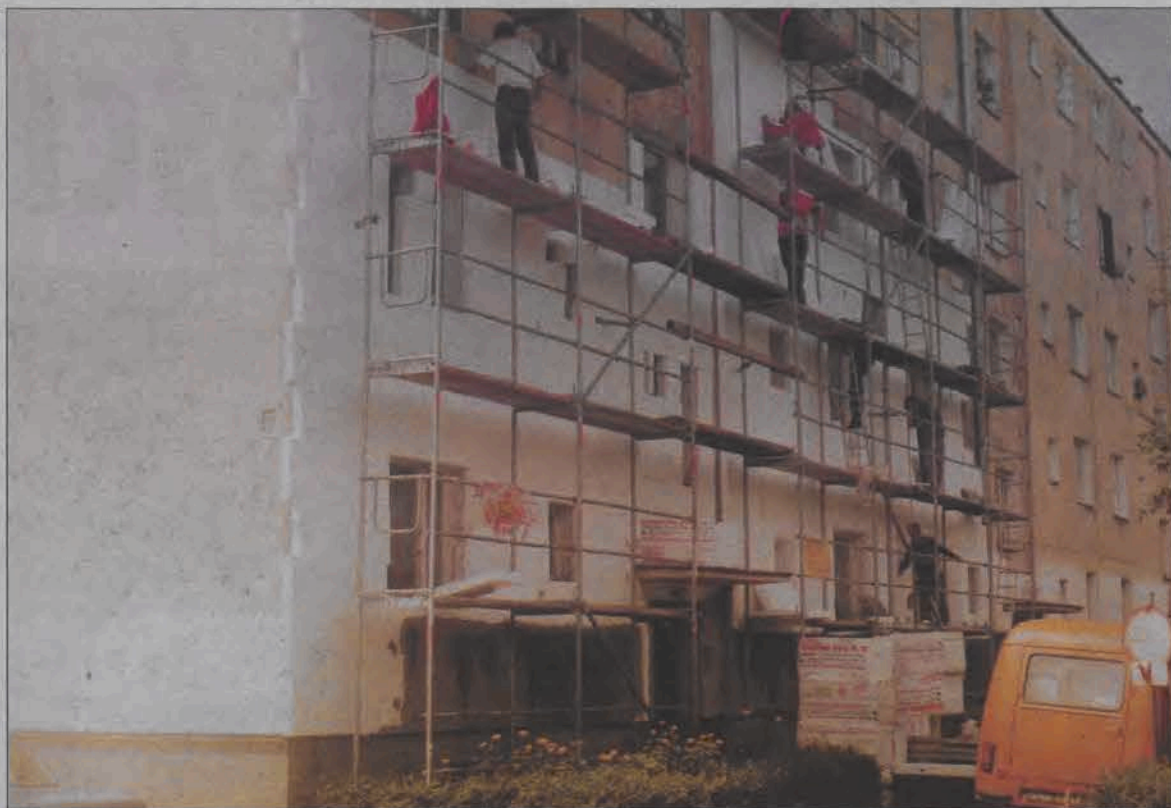
W następnym sezonie grzewczym mieszkańcom os. Reymonta łatwiej będzie oszczędzać na ogrzewaniu - trwają bowiem prace przy docieplaniu ich bloków.
