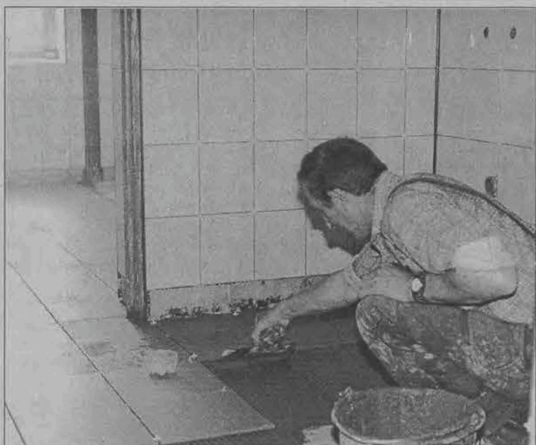
W rozbudowywanym gimnazjum w Zdunach wykonywane są obecnie prace wykończeniowe, pomieszczenia są malowane, układana jest glazura i terakota. Wszystko skończone ma zostać w ustalonym terminie, czyli do 1 września. Meble zamówione w firmie wykonującej meble szkolne i biurowe dostarczone mają być do szkoły na przełomie lipca i sierpnia. Uroczyste otwarcie odbędzie się najprawdopodobniej 1 września. (aw)
