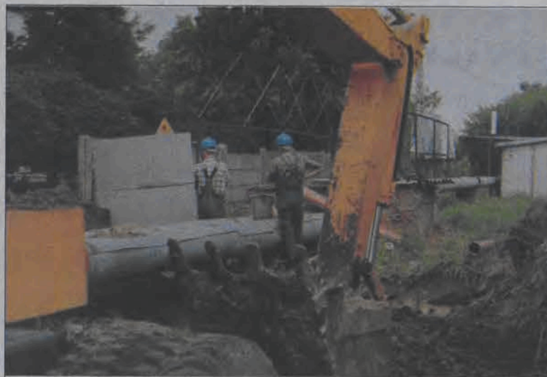
Dwa tygodnie potrwają jeszcze prace związane z budową kanalizacji sanitarnej na terenie targowiska miejskiego. Są to przygotowania do budowy nowych pawilonów handlowych. Zleceniodawca robót, czyli urząd miejski zapewnia, że roboty kanalizacyjne nie powinny utrudniać ruchu w obrębie targowiska w dni targowe, a szczególnie w piątek i sobotę, kiedy rynek jest najbardziej oblegany.
