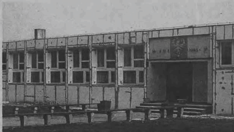
Remont budynku szkoły w Domaniewicach. Trwają prace przy termoizolacji budynku Szkoły Podstawowej w Domaniewicach. Wymieniono już wszystkie zniszczone drewniane okna, a także luksfery na sali gimnastycznej i korytarzu. Ocieplana jest frontowa część elewacji budynku. (mwk)
