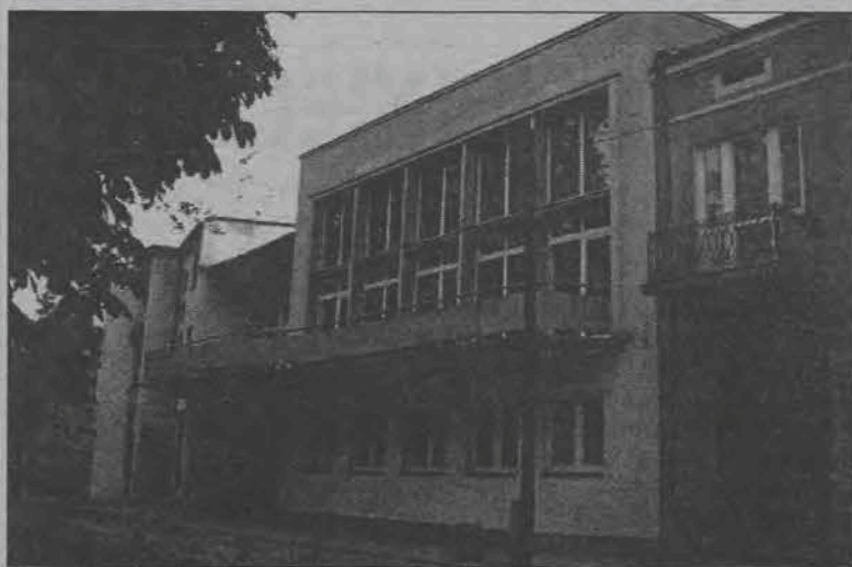
Dom Nauczyciela - jeszcze przed remontem elewacji.
