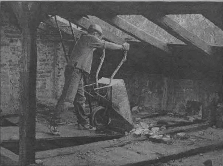
Trwa remont w dawnym Domu Kultury przy ul. Podrzecznej.
