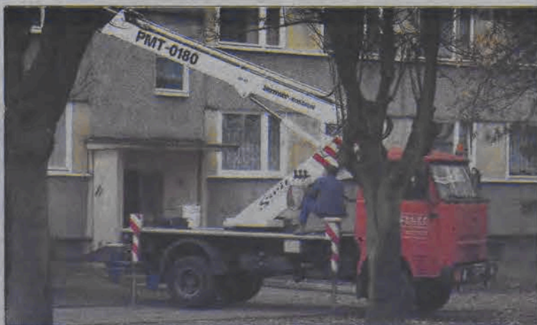
Podnośnik zainstalowany na samochodzie marki Star służy pracownikom Brygady Remontowo - Budowlanej z Łowickiej Spółdzielni Mieszkaniowej do remontowania rynien i części parapetów na blokach na osiedlu Dąbrowskiego. Podnośnik jest wynajmowany od spółdzielni Świt z Łowicza. Jest to tańsze niż przewożenie i ustawianie rusztowań i niszczenie przy tym ogródków przed blokami - mówi prezes ŁSM Armand Ruta.
