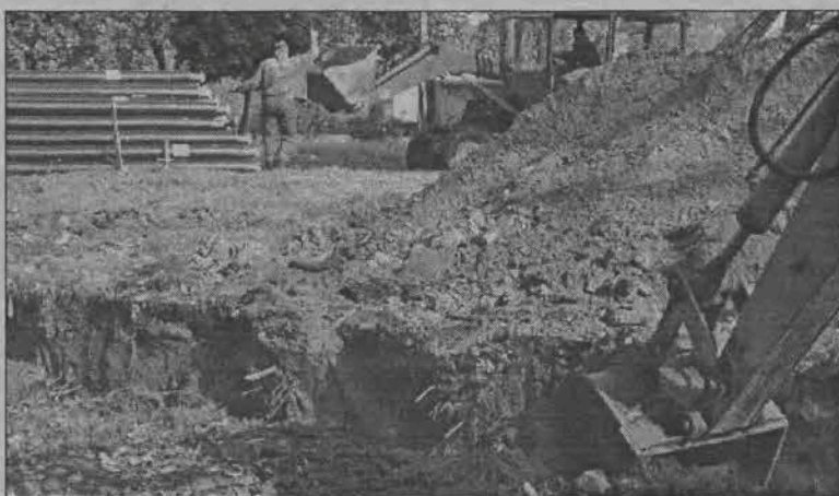
Rurę izolowaną pianką poliuretanową układają pracownicy toruńskiego przedsiębiorstwa „Energoterm”.
