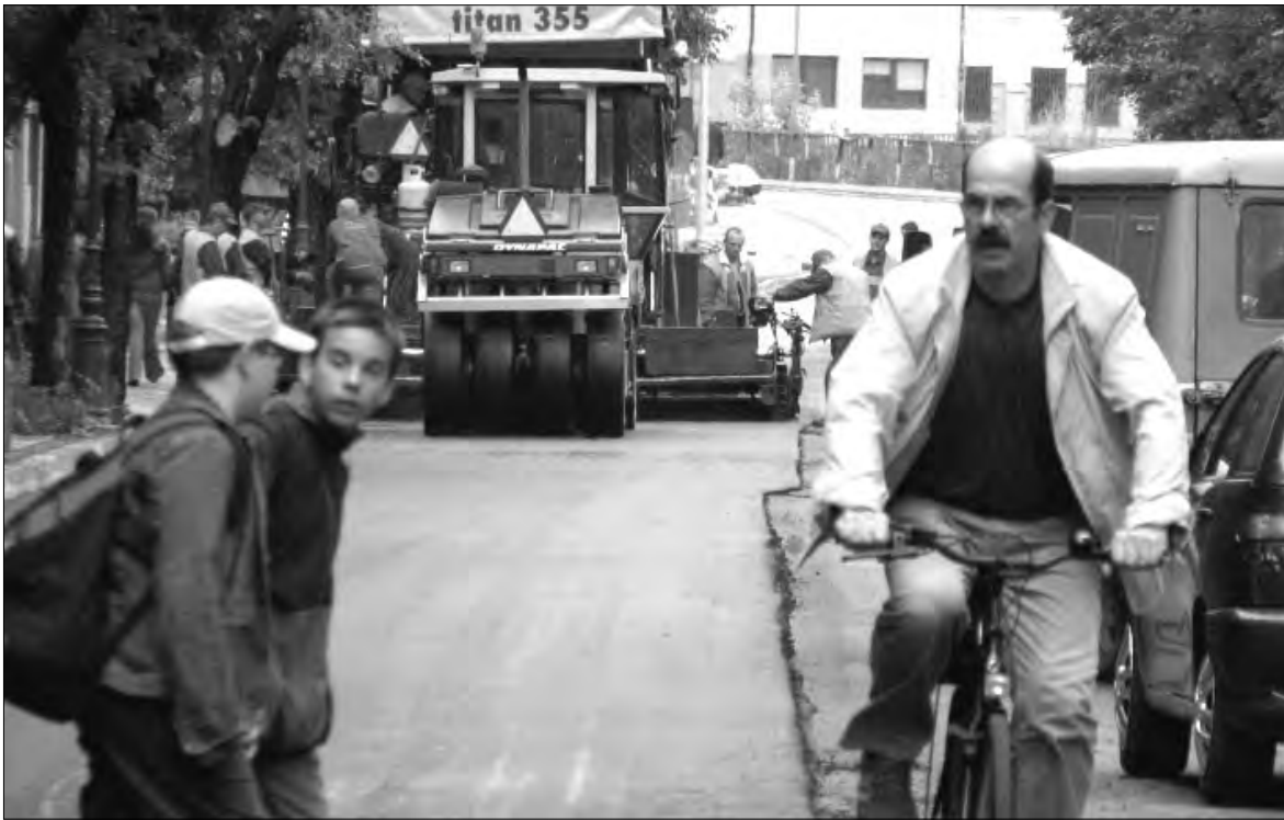
Prace na ulicy Mostowej i związane z nimi utrudnienia dla kierowców i pieszych potrwają jeszcze kilka dni.
